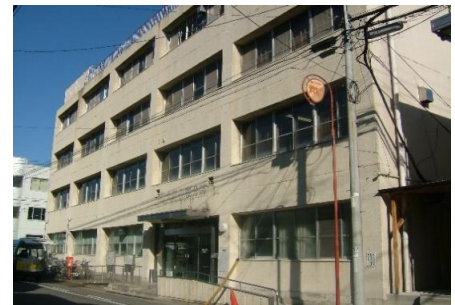
総合大雄会病院 管理棟
